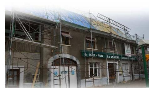
Le toit du bâtiment communal situé Place Camps a été refait. Les travaux ont consisté à recalquer l'ensemble de la charpente, à refaire la couverture en ardoises ainsi que toutes les gouttières et les descentes. C'est l'entreprise PELECQ de Louvie-Juzon qui a été retenue pour effectuer ces travaux. Ces travaux constituent une première étape dans la réhabilitation de ce bâtiment qui offre, de toute évidence, une multitude de possibilités pour l'avenir.
