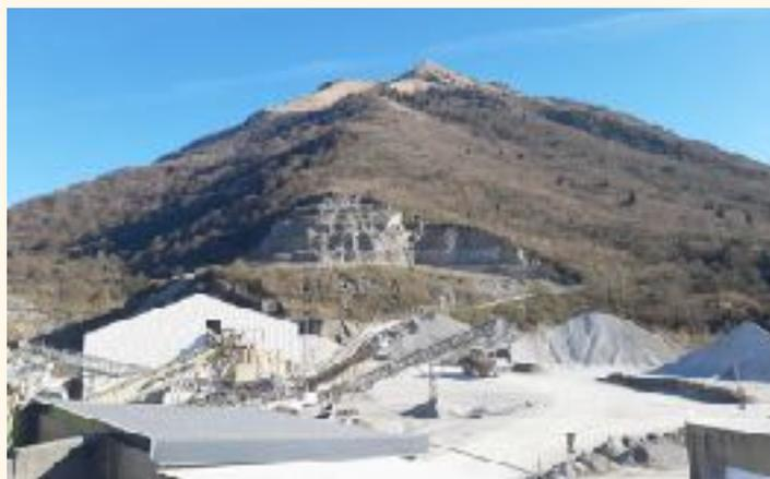
Le site de Louvie-Juzon est composé d'une carrière de calcaire et d'une centrale à béton. Sa surface d'exploitation est de 10 hectares sur une surface totale de 17 hectares pour une épaisseur maximale de 200 m. En plus de l'exploitation, sont installés : des zones de traitement, l'atelier, les bureaux, ainsi qu'une zone de stockage et la centrale à béton. Un arrêté
